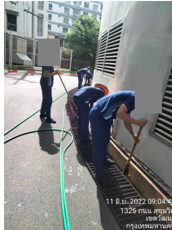
ภาพที่ 2.2-33 การขูดลอกท่อระบายน้ำ
